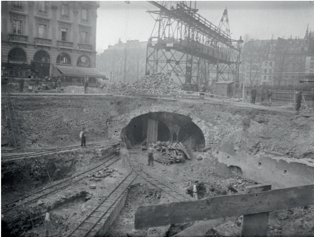
Construction à ciel ouvert et au fond, selon la technique de la galerie boisée
